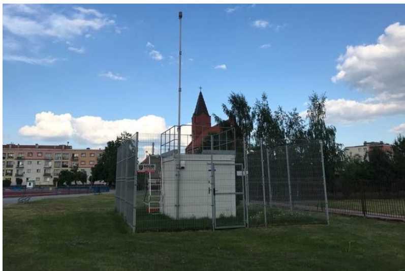
rys. 14. Automatyczna stacja pomiarowa jakości powietrza w Elku
