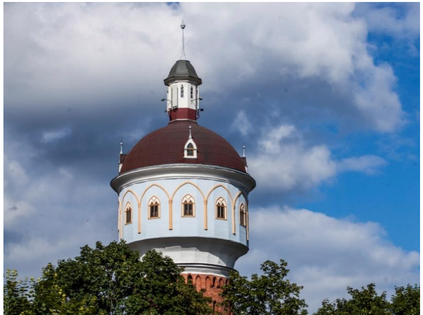
Wieża Ciśnień fot. Urząd Miasta Ełku
