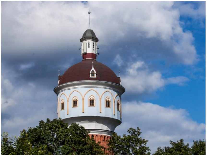
Wieża Ciśnień fot. Urząd Miasta Ełku
