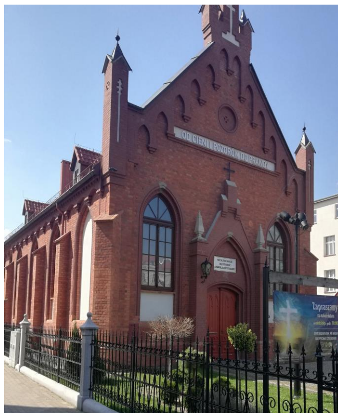
Rysunek 5 Zmodernizowany budynek Zboru Kościoła Chrześcijan baptystów przy ul. 3 Maja 8 w Ełku
