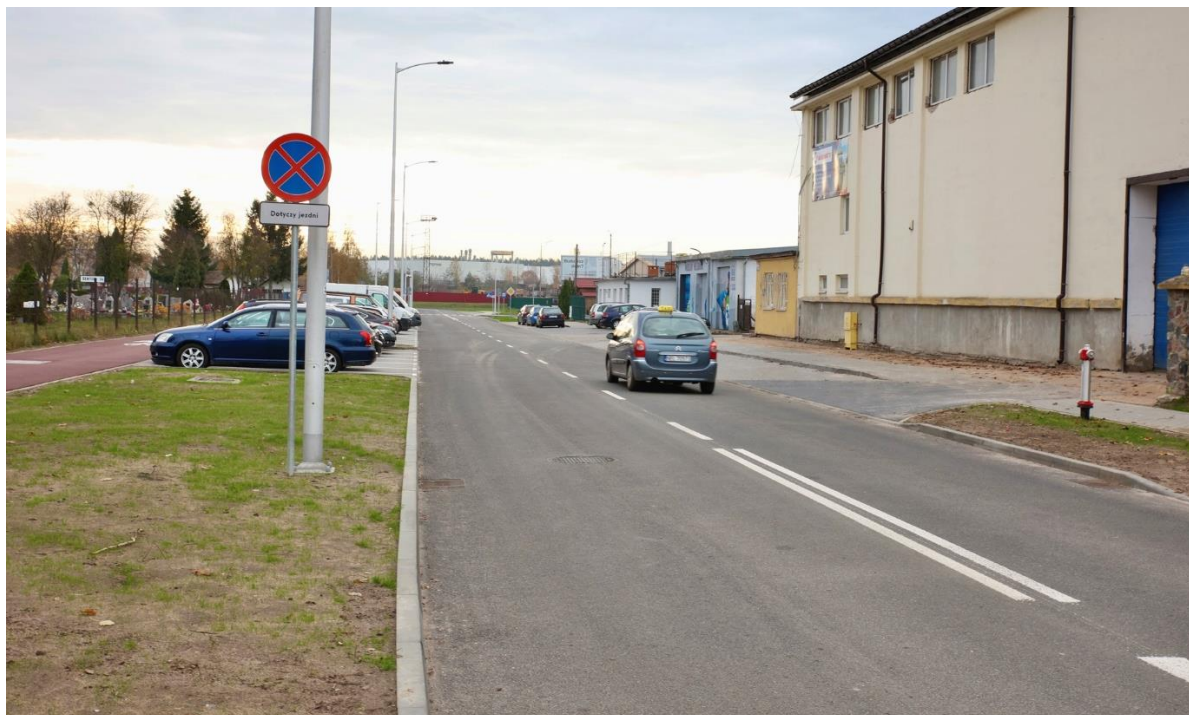
Rysunek 7 Ulica na terenie strefy ekonomicznej po przeprowadzonej modernizacji (fot. UM Ełku)
