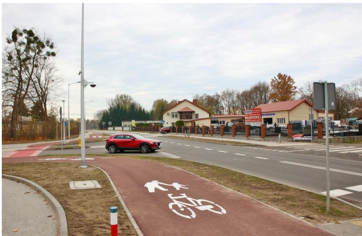
Rysunek 3 Ulice Sikorskiego i Towarowa po przebudowie (źródło: UM Ełk)
